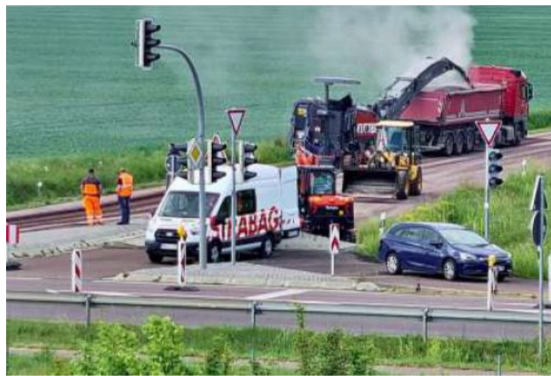
Die Strabag baut am Ende der B 6n in Richtung Prosigk.
