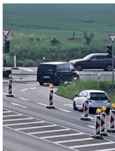
Vor dem Kreisels zur Landkreisverwaltung werden die Fahrzeuge auf die Umleitung abgeleitet.
